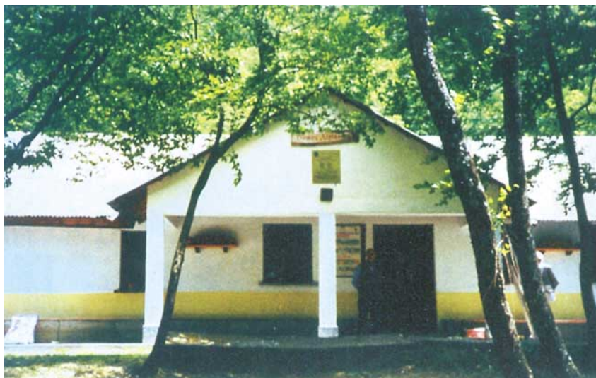
La "Domus Alpina", rifugio in Alta Val Borbera, soggiorno per alpini e familiari e base operativa per il Nucleo di Protezione Civile.
